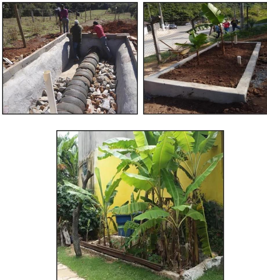
Figura 14 – Detalhe Construtivo – TEvap
