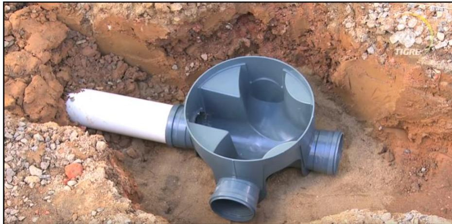
Figura 18 – Detalhe da instalação de uma Caixa de Passagem/ Inspeção propostas pela SAMENCO
