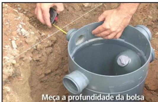
Figura 16 – Detalhe da instalação de uma Caixa de Gordura
