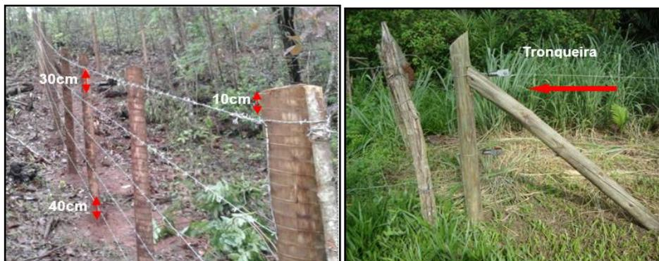
Figura 20 – Fotos Ilustrativas do modelo adotado para cercamento das nascentes
