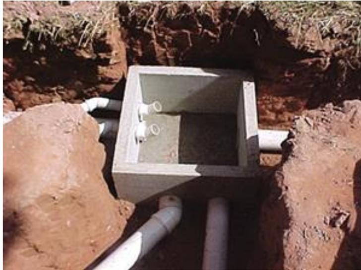
Figura 19 – Detalhe da instalação de uma Caixa de Passagem/ Inspeção propostas pela AGEDOCE
