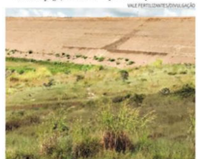
Empresa fez obras para contornar a erosão provocada pela chuva
