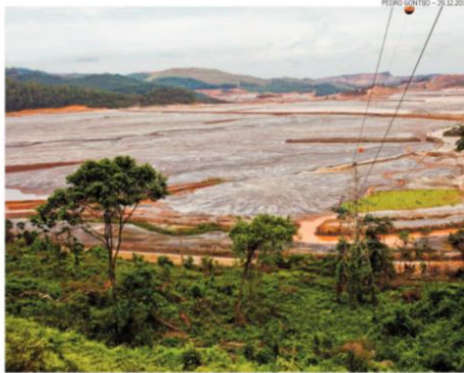
Tragédia. Rompimento da barragem da mineradora Samarco, em novembro de 2015, matou 19 pessoas
