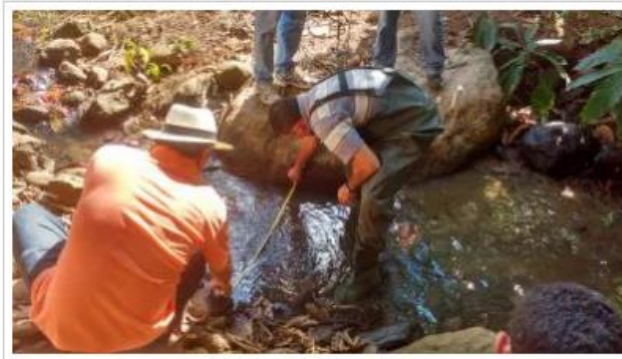
Instalação de régua de medição de volume d'água na propriedade do senhor Vagner Cochetto. Foto: Divulgação
