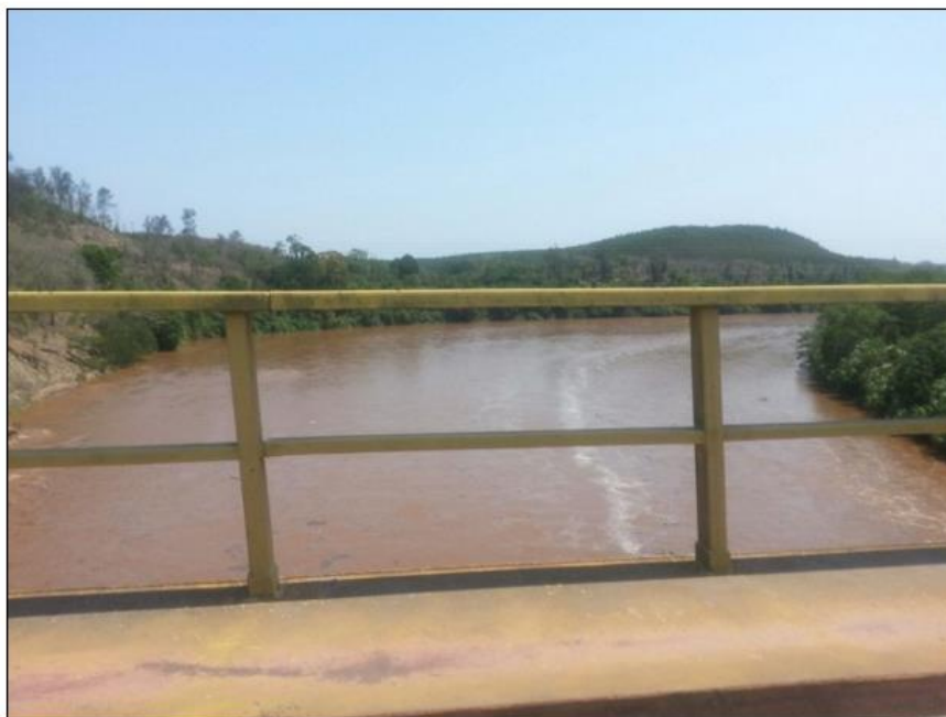
Ponte Metálica, na BR 458
