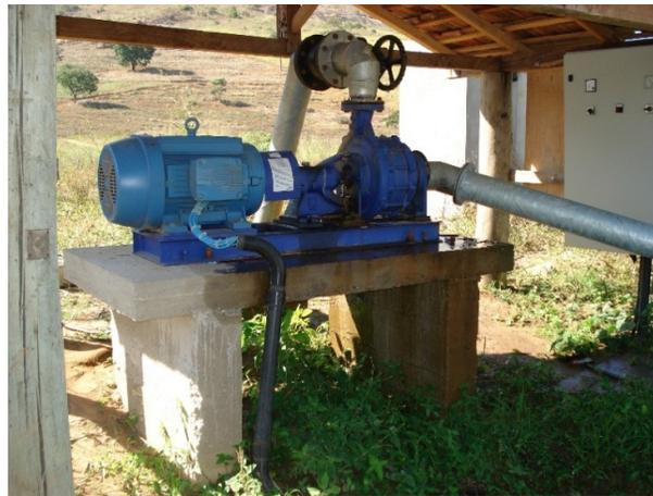
FIGURA 3. Motobomba centrífuga.
