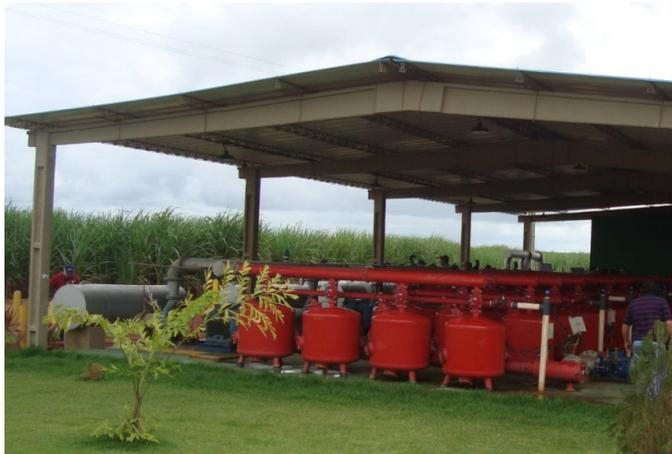
FIGURA 18. Estação de controle de sistema de irrigação localizada, com diversos filtros de areia.
