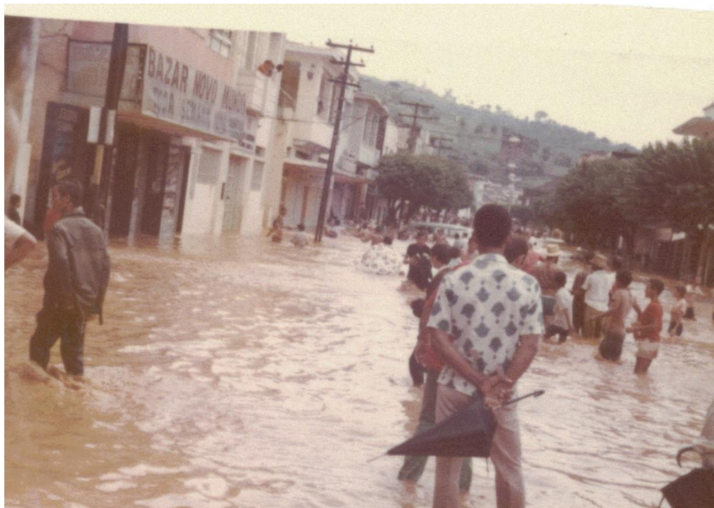
Figura 72 – Enchente ocorrida pelo transbordamento do rio Caratinga na cidade de Caratinga - MG, em janeiro de 1973.
