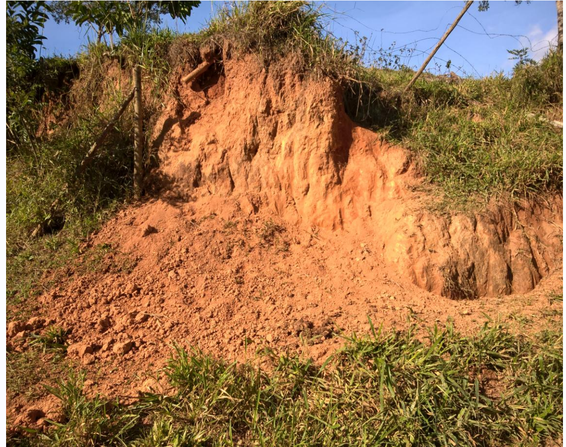
Presença marcante de erosão na propriedade do Antônio Nascimento
