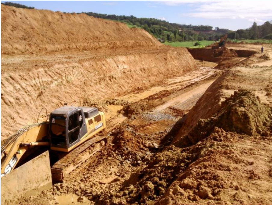
Execução do interceptor Caratinga trecho I, próximo ao Parque de Exposições.
