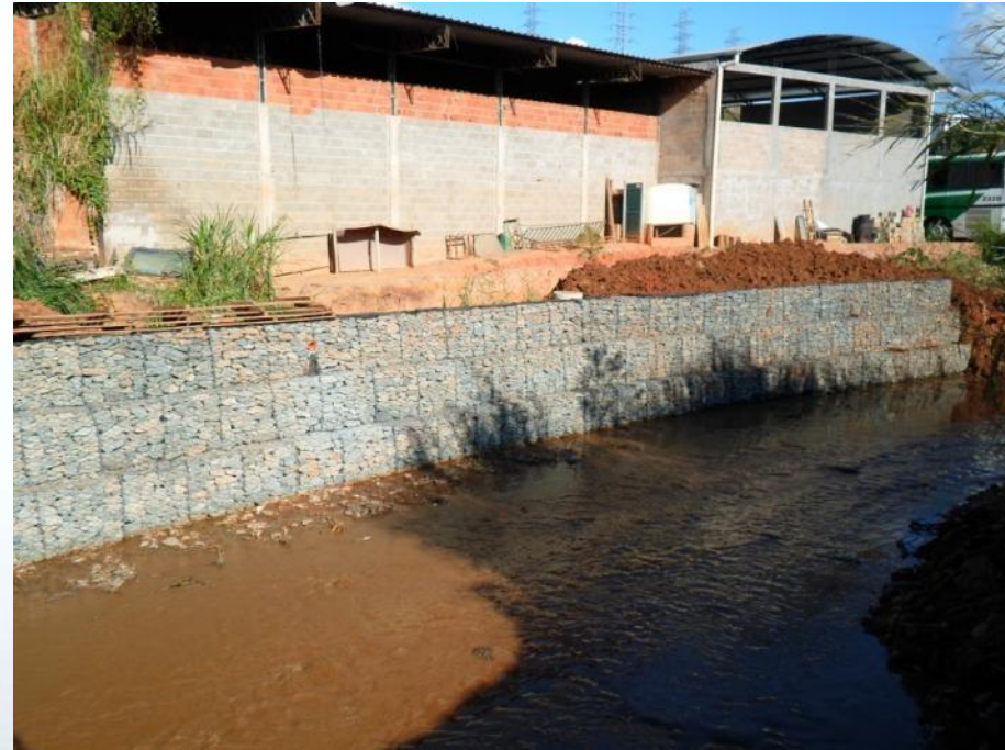
Contenção com gabião, próximo a EEEB-01.
