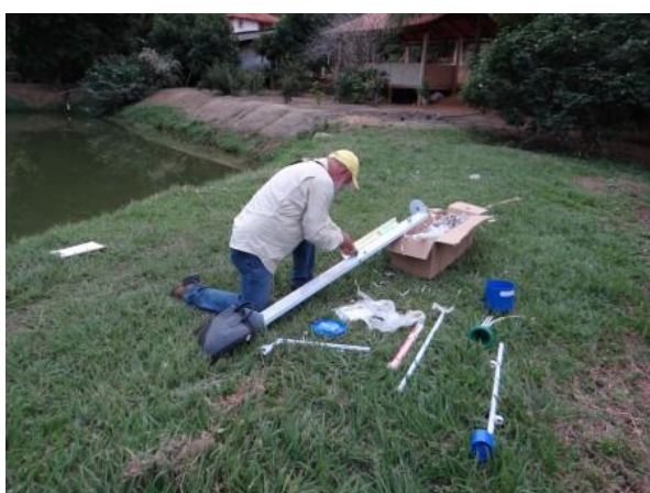
Figura 12 - Instalação do Irrigômetro, na propriedade do produtor Flávio Marçal em Alvarenga - MG.
